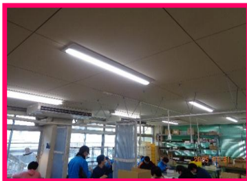
1階作業場の照
