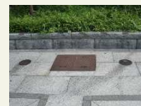
水道メーター ボックス (親メーター)
