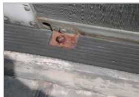
室外機金属部分
