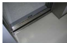
エレベーター扉の敷居溝
